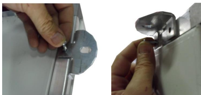
Figura 1 - Fissaggio delle staffe fornite a corredo
