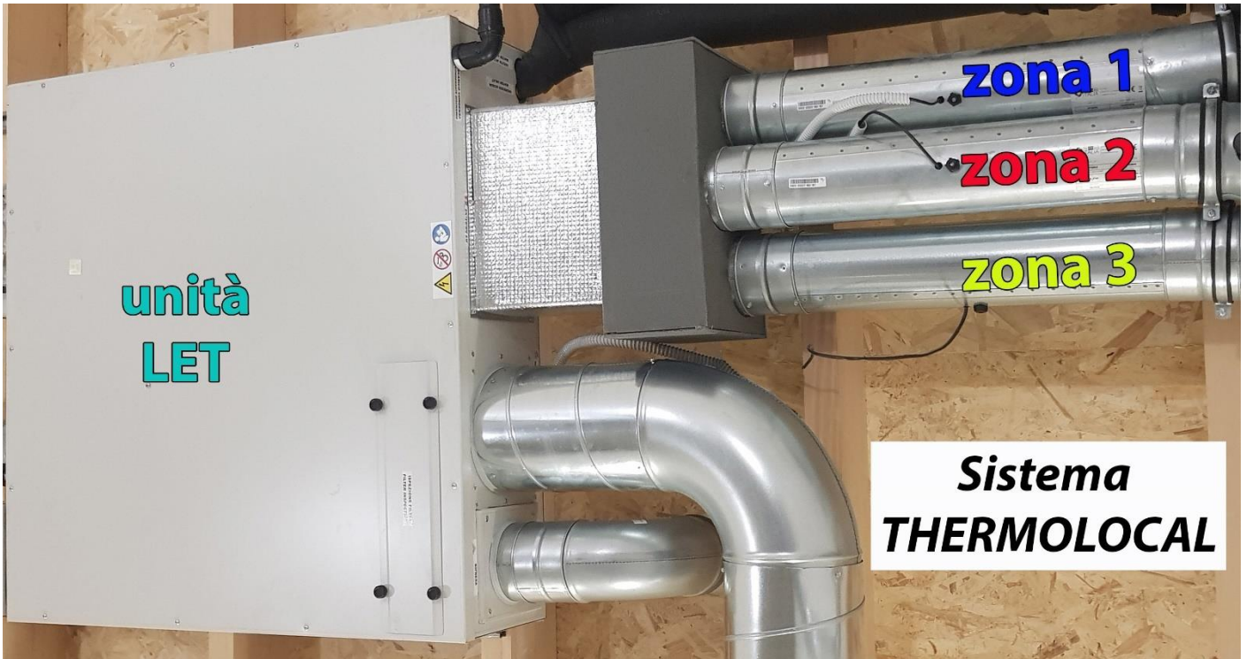
Figura 7 – esempio di installazione cin sistema Thermolocal
